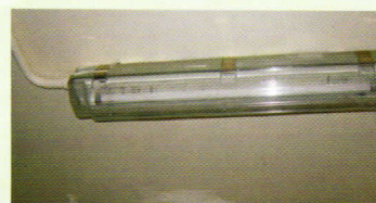
燈具加裝感應裝置工程
