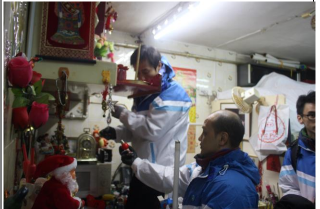
中華煤氣公司義工隊正在為富山邨居民 更換 LED 燈具
